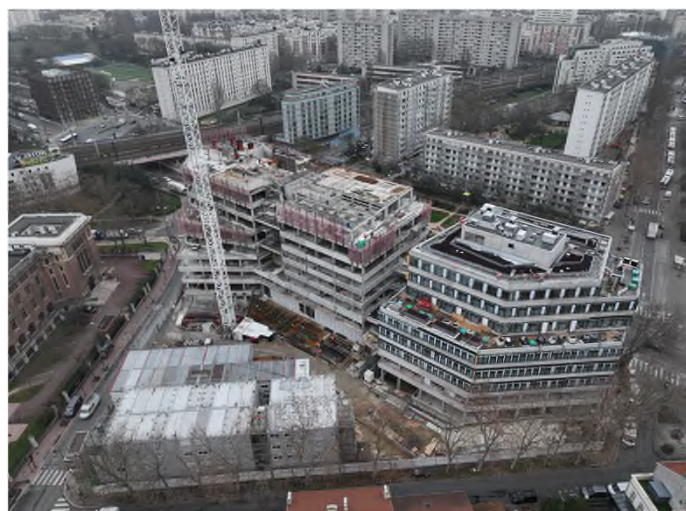
Vue d'ensemble du projet
