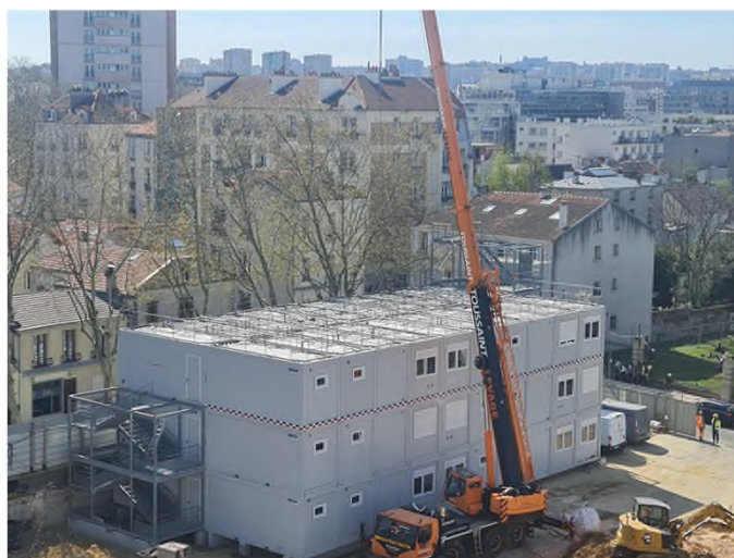
Mise en place de la base vie rue Legrand
