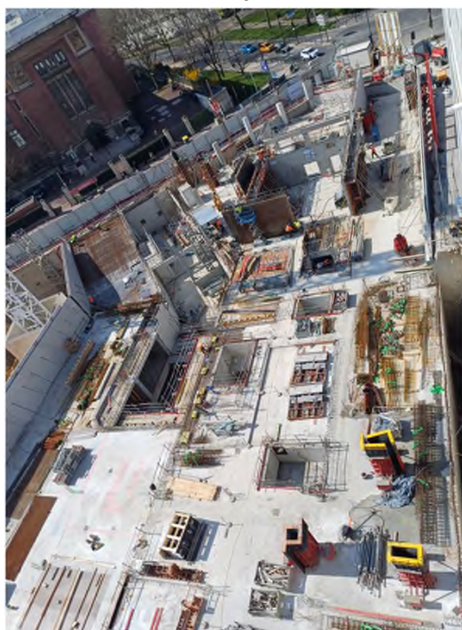
Sous-sol côté avenue Pierre Larousse
