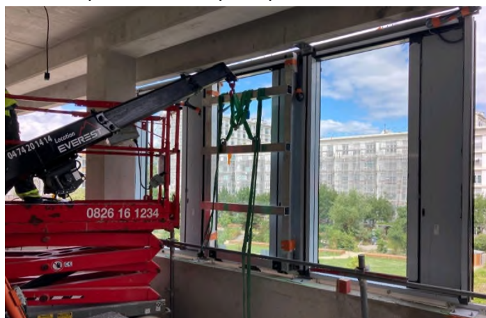
Mise en place d'un élément de façade du témoin
