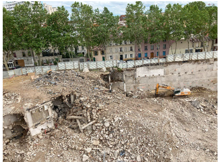
Fin de la déconstruction en superstructure
