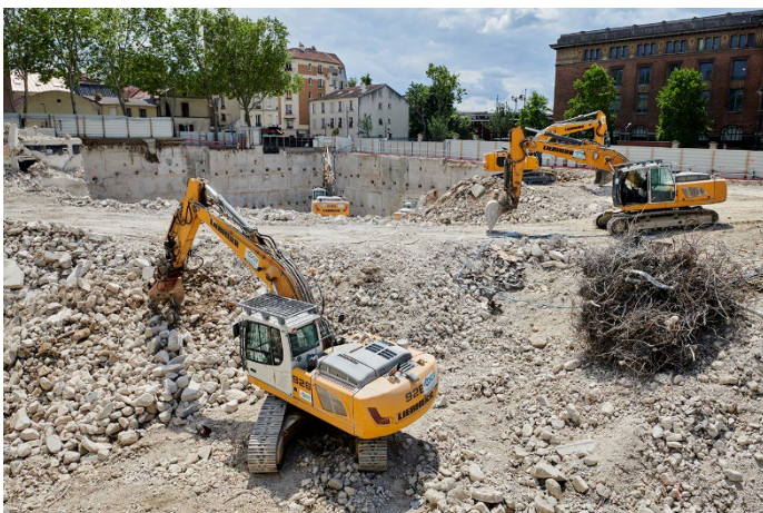
Séparation des gravats et éléments métalliques
