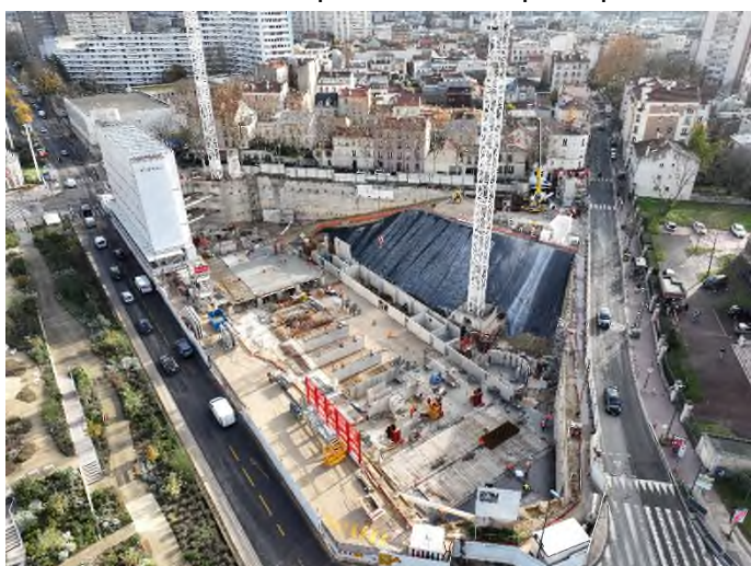
Travaux des fondations et des sous-sols
