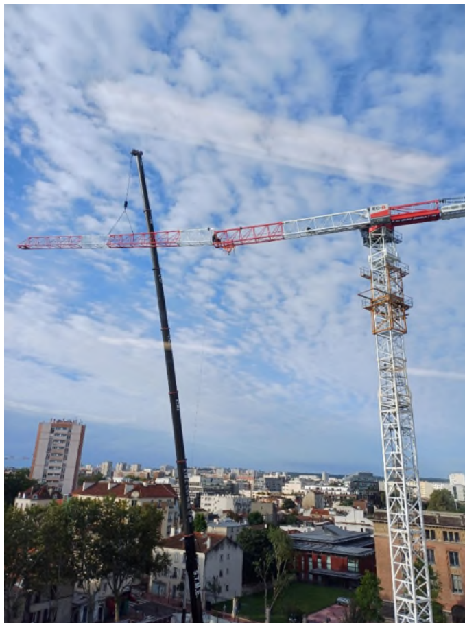
Montage de grue
