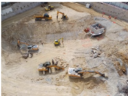
Travaux de terrassement
