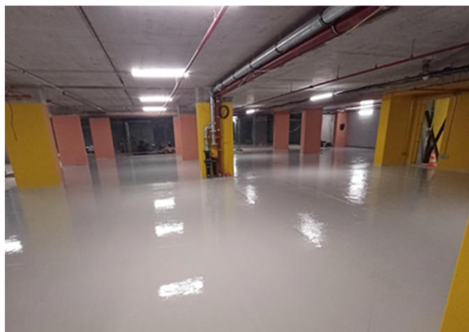
Zone témoin sous-sol
